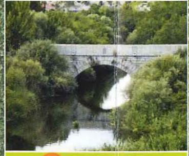
1 Puente de Herrera
