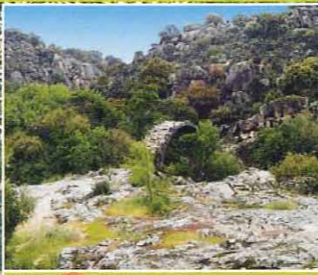
2 Puente de Alcanzoria
